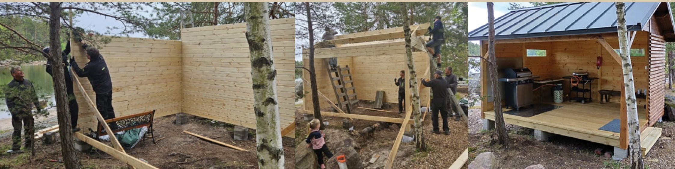
Grilltaksbyggande på Killingholmen sommaren 2025 Killingholmenin grillikatoksen rakennusta kesällä 2025 (Raimo Kilpinen, Christer Helenelund)
